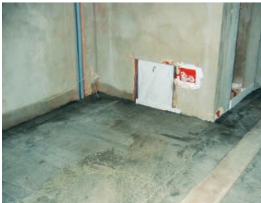
Рис. 1. Встроенный бокс для контроллера
