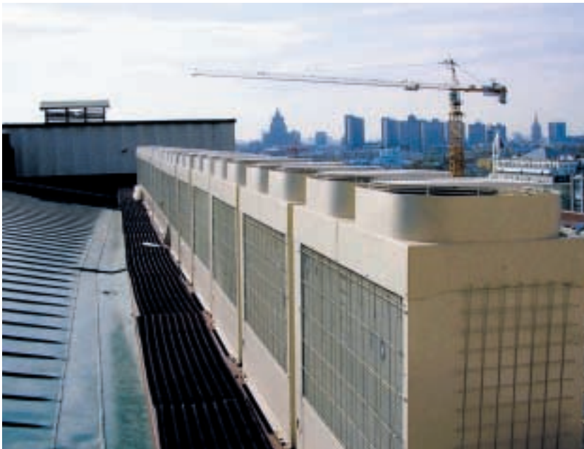
Мультизональная система кондиционирования здания Государственной Думы РФ серии S GENERAL
