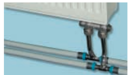
Двухтрубная нижняя подводка радиатора к отопительной системе
