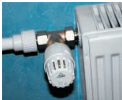
Верхнее боковое подключение радиаторов к отопительной системе
