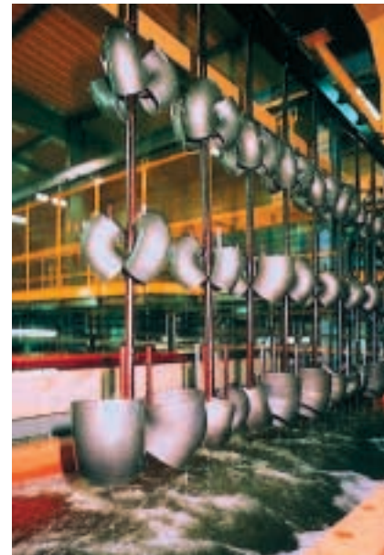
Нанесение покрытия на фасонные части PAM-GLOBAL
