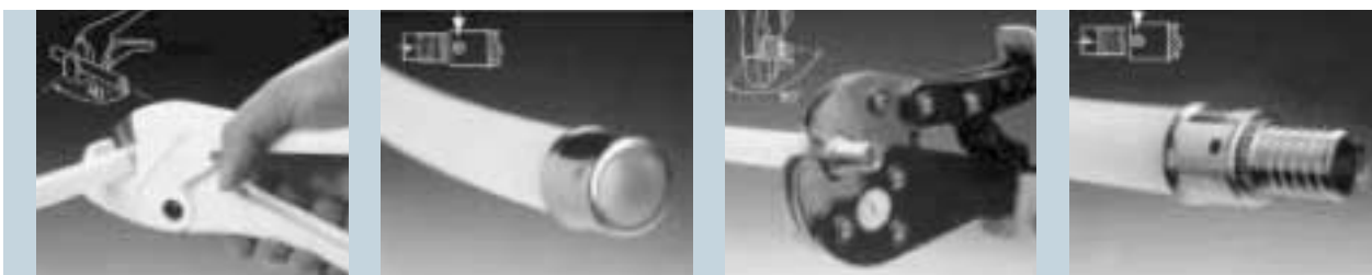
1. Отрезать трубу RAUBASIC под прямым углом ножницами для резки труб
