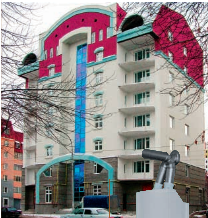
Жилой дом с поквартирным отоплением, г. Уфа.
