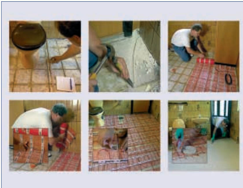
Установка нагревательного мата devimat™ на поверхность пола
