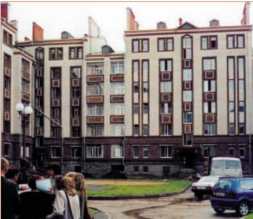
Жилой дом с поквартирным отоплением, г. Казань
