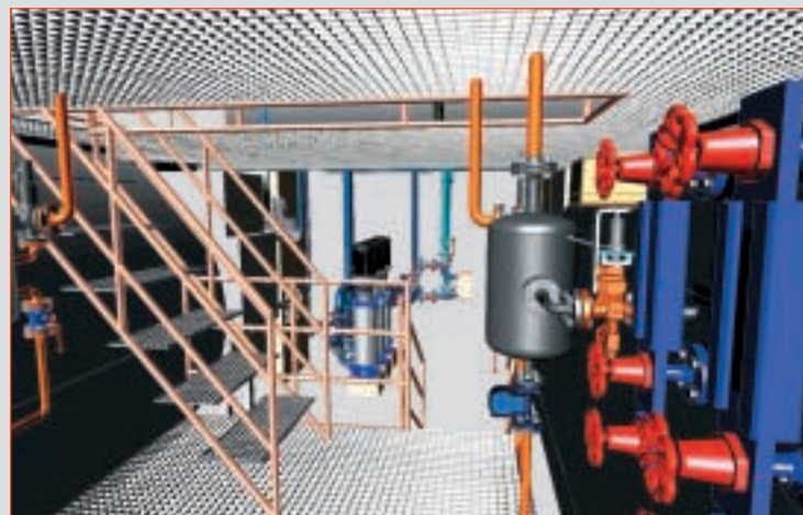
Вид нижней площадки обслуживания. Справа индикаторы уровня воды, далее вентиль продувки по солесодержанию, на заднем плане три питательных насоса котловой воды. За котлами располагаются экономайзеры.
