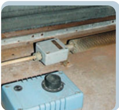
Рис. 7. Дополнительный электронагрев для стояночного режима
