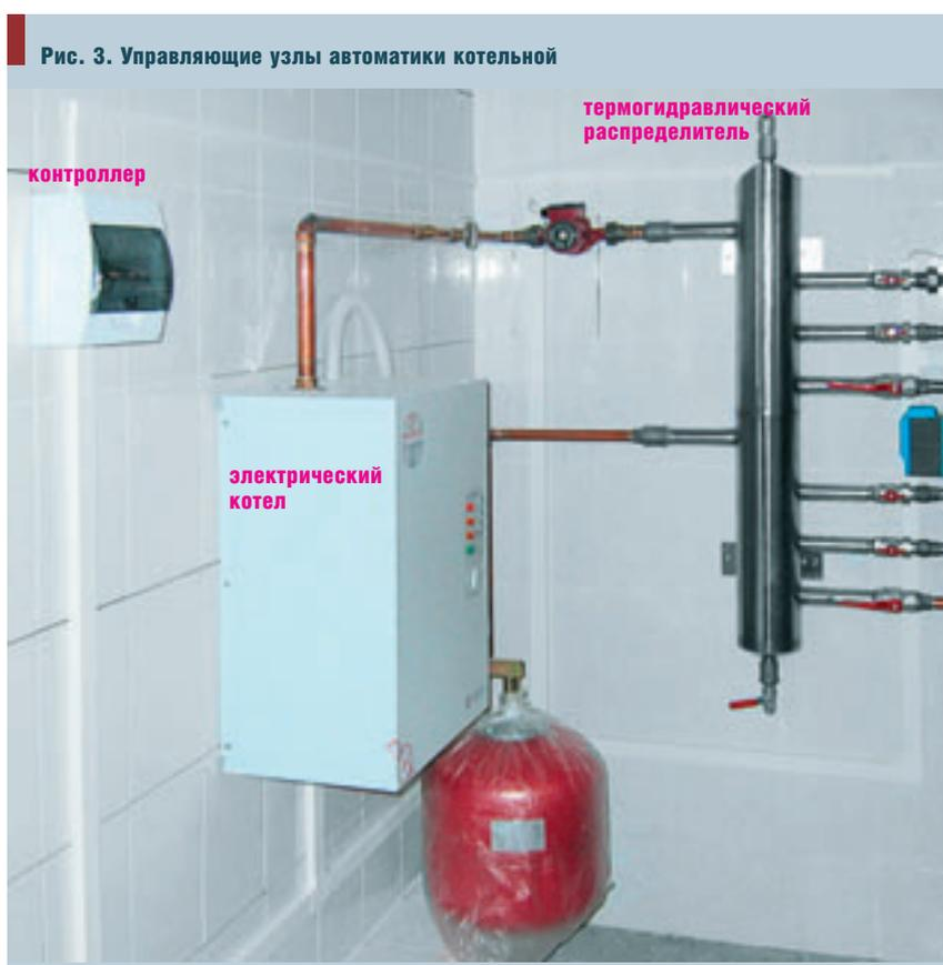
зная температуру на улице, посредством трехходового клапана  $K_2$ , поддерживает в контуре температуру теплоносителя согласно выбранной температурной кривой.
