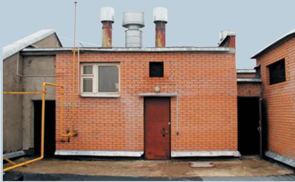
Специфика крышных котельных требует принятия необходимых мер, обеспечивающих шумогашение и снижение вибраций от работающего оборудования. Это достигается выбором соответствующего оборудования, а также использованием технологии «плавающего пола» помещения котельной и установкой виброкомпенсаторов на всех подводящих и отводящих трубопроводах. Эффективность этих мер позволяет жильцам забыть о том, что на крыше дома находится работающая котельная.
