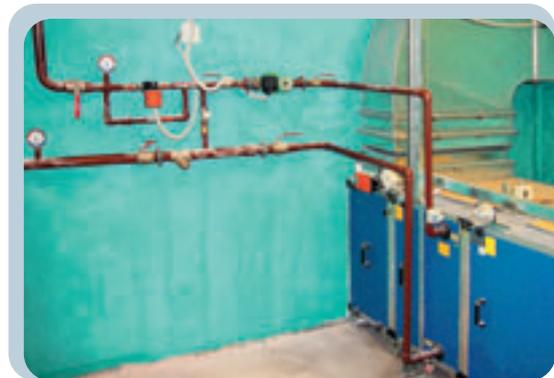
Рис. 6. Узел обвязки калорифера с двухходовым клапаном и насосом
