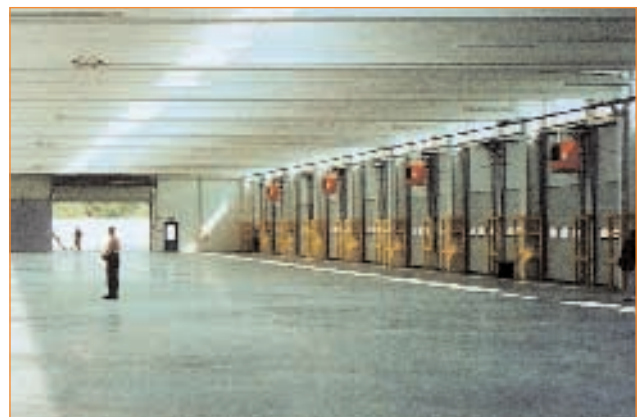
Рис. 2. Склад Шенкер, Эстония, 2003 г. Двенадцать обогревателей Robur серии М — 368 кВт
