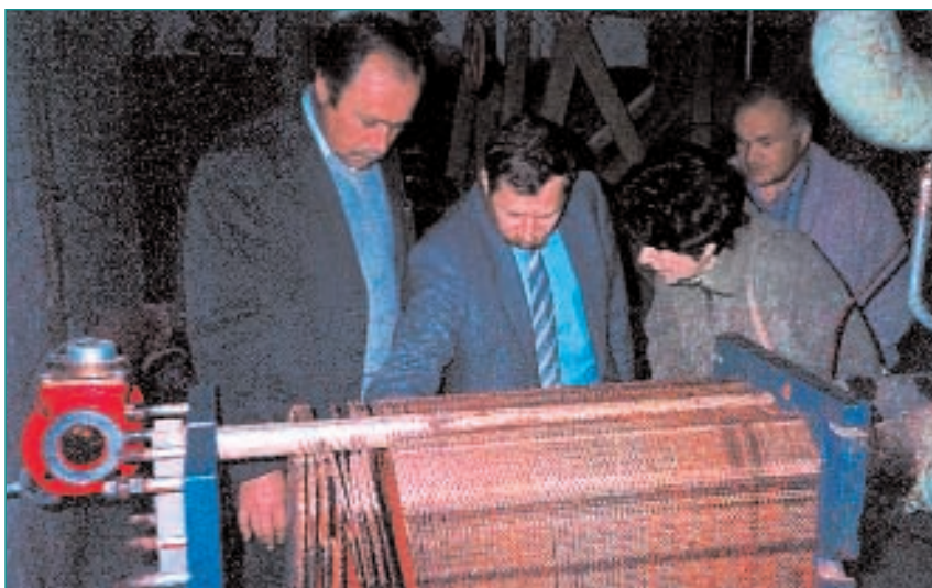
Московская обл., г. Мытищи, МУП «Теплосеть», ЦТП №17. УПОВС «Макмир» производительностью 25 м³/ч обеспечил защиту от накипи теплообменника «Альфа Лаваль», другого теплового оборудования и сетей
