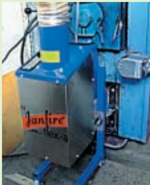
Рис. 3. Сжигатель гранул, установленный на бывший котел на дизельном топливе
