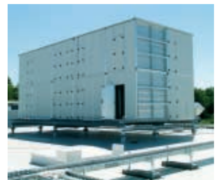
Рис. 6. Монтаж крышного кондиционера
