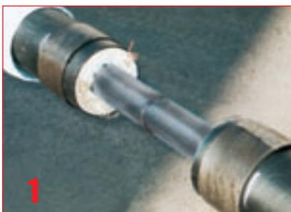
1. Муфта устанавливается на трубу перед сваркой стыка. Упаковочная пленка не снимается до начала изоляции стыка!
