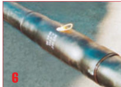
6. Заливочное отверстие заливается дренажной пробкой. В процессе вспенивания незначительное количество пены вытечет через дренажное отверстие пробки; это свидетельствует о полном заполнении объема стыка.
