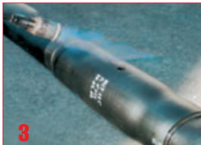
3. Края муфты усаживаются мягким пламенем пропановой горелки.
