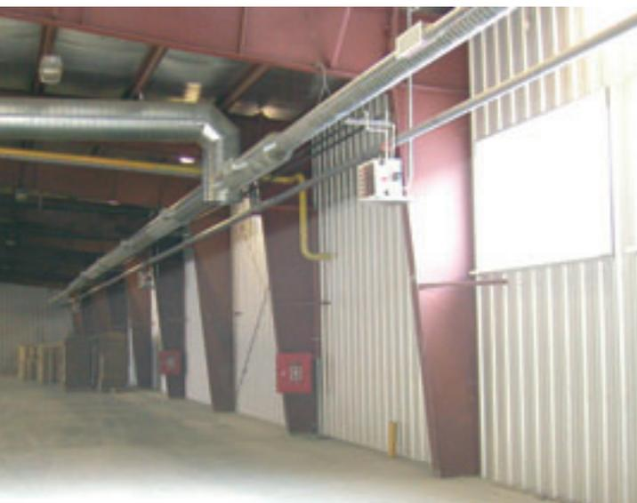
Завод «Вимм-Билль-Данн» по производству минеральной воды (г. Великий Новгород). В помещениях предприятия (производственные помещения для сироповарения, склад готовой продукции и склад сырья, электрощитовая, компрессорная) установлено 11 приточно-вытяжных установок с камерами смешения (рециркуляцией) и калориферами. Производственные цехи оснащены воздушно-отопительными агрегатами LHW D.
