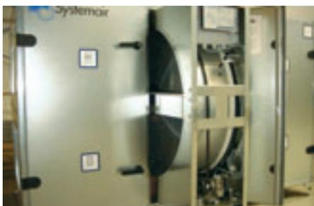
данные: Рекуперационная установка Systemair тип **Gazelle-10-C** производительностью 10 000 м³/ч, КПД рекуператора 80%, температура в помещении 22°C, средняя температура за отопительный период -3,6°C, длина отопительного периода 213 дней, время работы установки 10 часов в сутки, стоимость электроэнергии 0,8 руб. за 1 кВт/ч (электрический догрев), стоимость тепла при догреве водяными калориферами 0,24 руб. за 1 кВт/ч.
