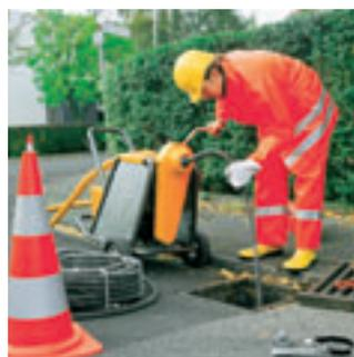
обратного хода при утечках; манометр со шкалой, градуированной в бары; самовсасывание на расстоянии до 2 м; подача чистящего средства происходит помимо насоса, не повреждая прокладки насоса высокого давления.
