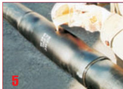
5. Теплоизоляция стыка. В чистую емкость отдозировать необходимое по объему заливаемого стыка количество компонентов А и В (в пропорциях согласно технологическим инструкциям фирм-поставщиков) и перемешать их. Через отверстия залить в стык смесь компонентов ППУ.
