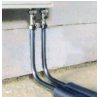
Рис. 1 Присоединение «из пола»
