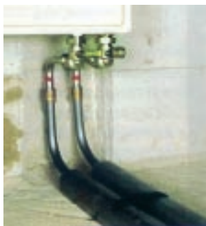
Рис. 2 Присоединение «из стены»
