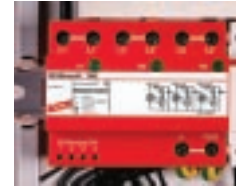
Образцы УЗП для цепей питания фирмы DEHN.
