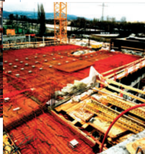
Здание фирмы Бурда (Оффенбург) 10 000 м²
