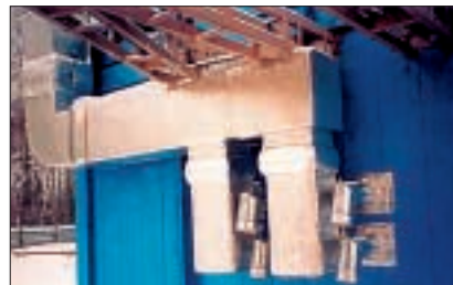
Изоляция на открытом воздухе. Материал «Термашит Алу Стукко» с алюминиевым покрытием
