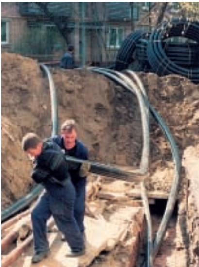
Теплоизолированные трубы из сшитого полиэтилена, выпускаемые ЗАО «Завод АНД Газтрубпласт», широко применяются в Москве и Подмоскowie
