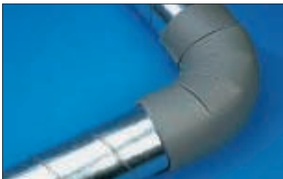
Сегментирование на изогнутом участке трубы. Швы должны быть покрыты армированной лентой
