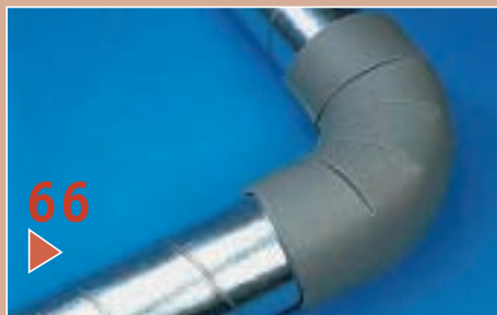
66 Монтаж тепловой изоляции для инженерных систем. Анализ популярных ошибок
