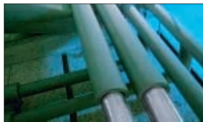
Воздуховоды с круглым сечением могут быть изолированы как трубным, так и листовым материалом
