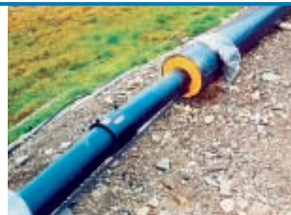
Полимерные трубы с подогревом на о. Шпицберген (Норвегия)
