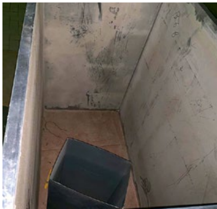
Рис. 2. Загрязнения внутренних поверхностей воздуховодов
