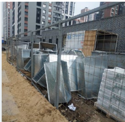
Рис. 1. Хранение вентиляционных изделий на объекте (слева) и на прилегающей территории
