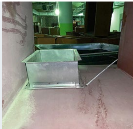
Рис. 2. Загрязнения внутренних поверхностей воздуховодов
