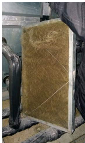
■ Рис. 6. Чистый (слева) и загрязнённый воздушные фильтры приточной вентиляции
