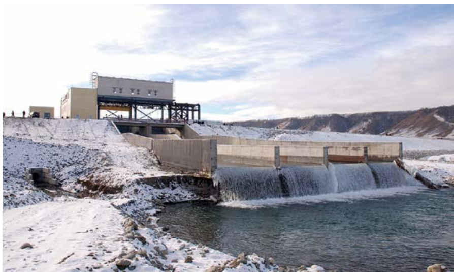
■ Малая Зеленчукская ГЭС-ГАЭС на реке Большой Зеленчук (Республика Карачаево-Черкесия)
