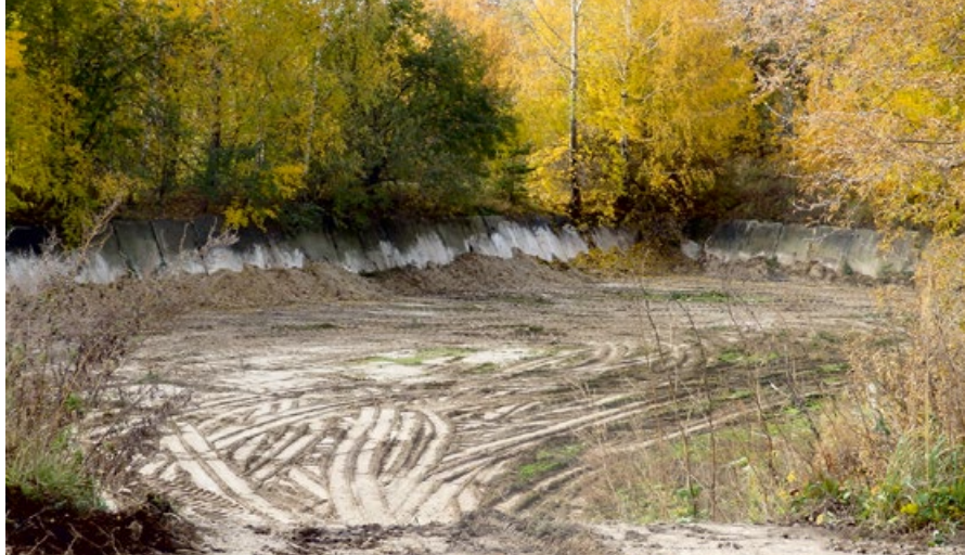
:: Иловая площадка после вывоза почвогрунта [1]
