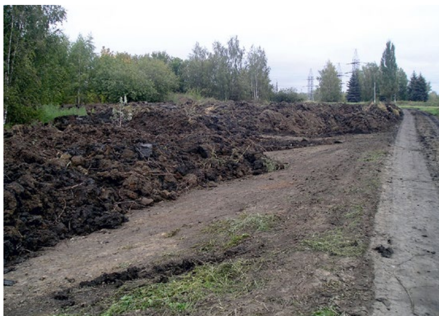
:: Процесс буртования осадка на иловой площадке [1]
