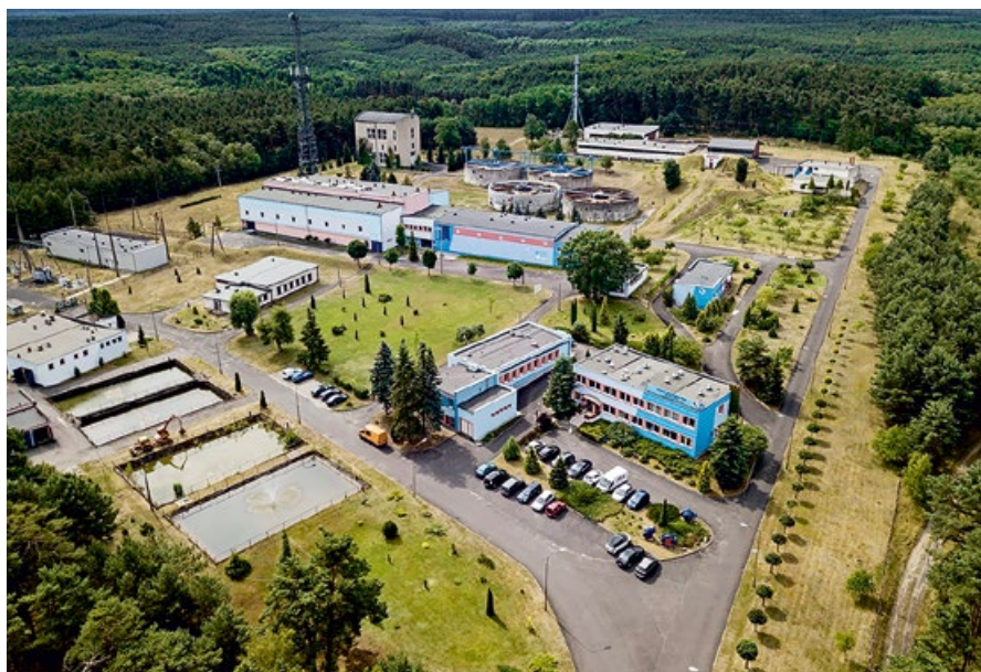
•• Рис. 3. Водопроводные очистные сооружения Zawada (Польша)
