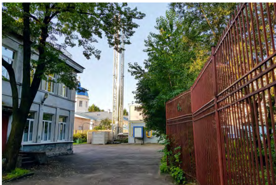
Рис. 1. Котельная на территории детского сада — начальной школы №687 (Санкт-Петербург)
