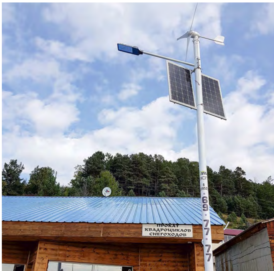
Рис. 3. Бытовая ветроэлектрическая установка (пос. Листвянка, Иркутская область)
