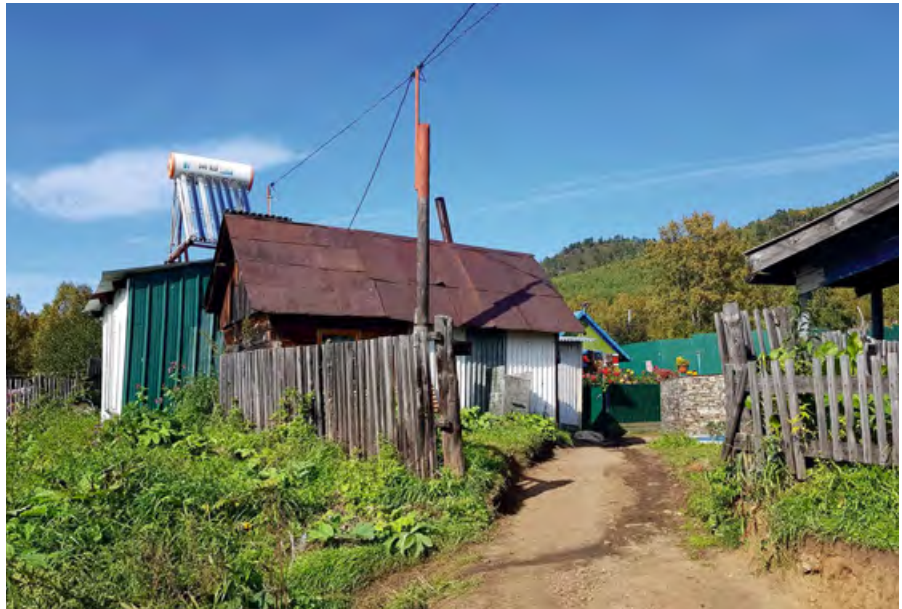
• • Рис. 2. Гелиоколлектор на крыше частного жилого дома (пос. Ангасолка, Иркутская область)
