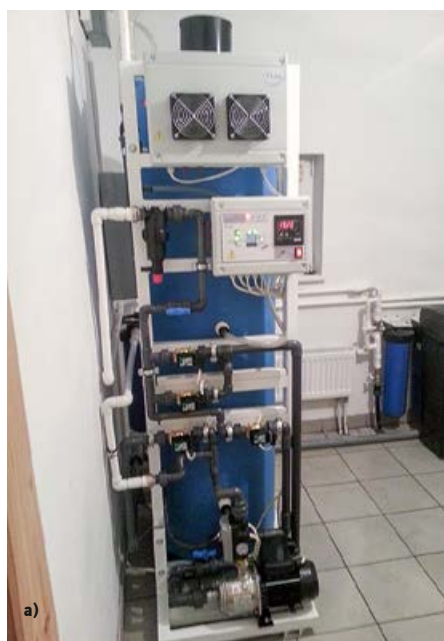
Рис. 2. Аппаратное оформление технологии производительностью 2 м³/ч (а) и 15 м³/ч (б)
