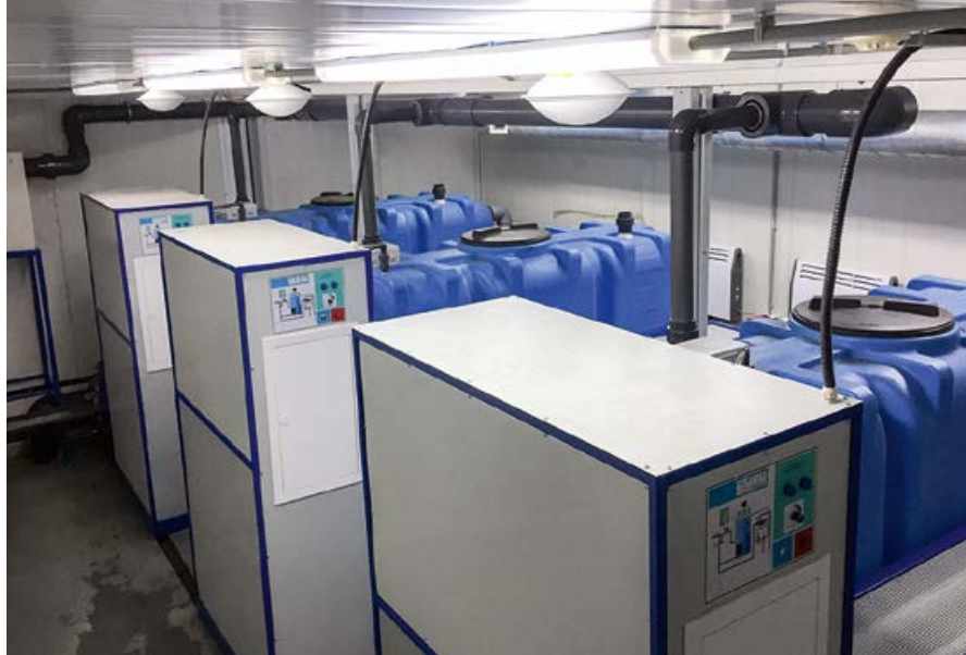
Рис. 3. Аппаратное оформление технологии производительностью 45 м³/ч
