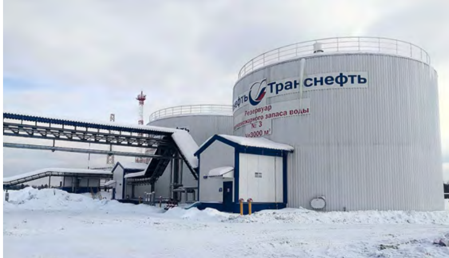
Резервуары противопожарного запаса воды РВС (3000 м³) компании ПАО «Транснефть»
