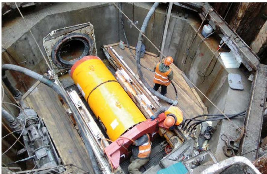
:: Фото 2. Общий вид проходческого щита в шахте
