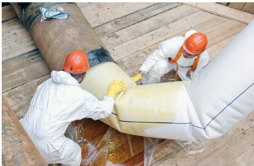
:: Фото 4. Подача полимерного чулка в трубопровод
