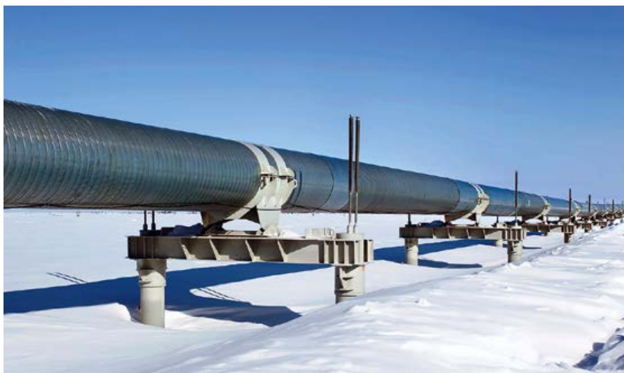
:: Фото 1. Надземная прокладка трубопровода
