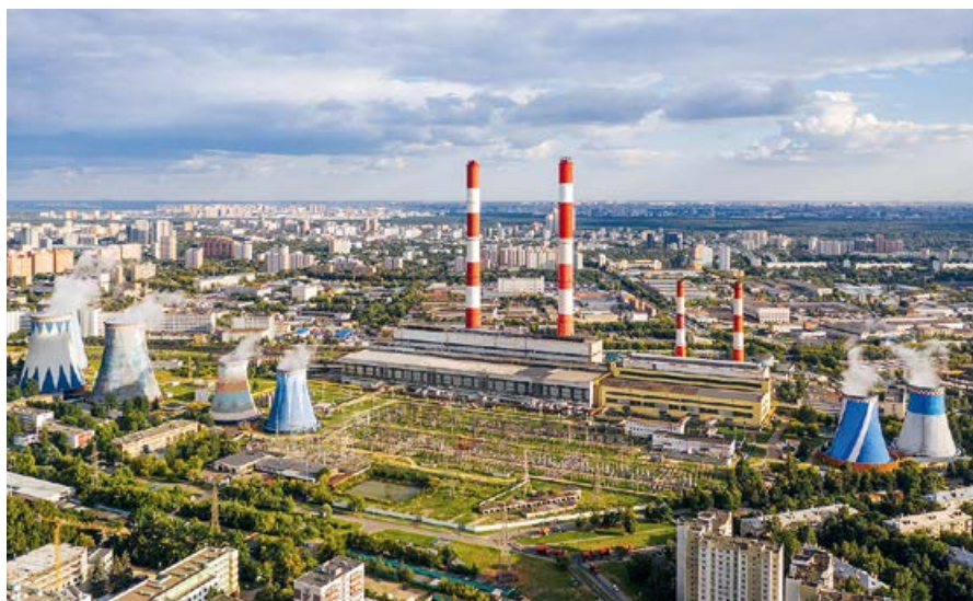
■ Московская ТЭЦ-23 (1420 МВт, 4530 Гкал/ч) введена в эксплуатацию в 1966 году
