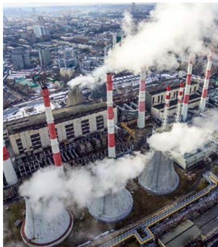
Котлотурбинное отделение №2 ТЭЦ-20
