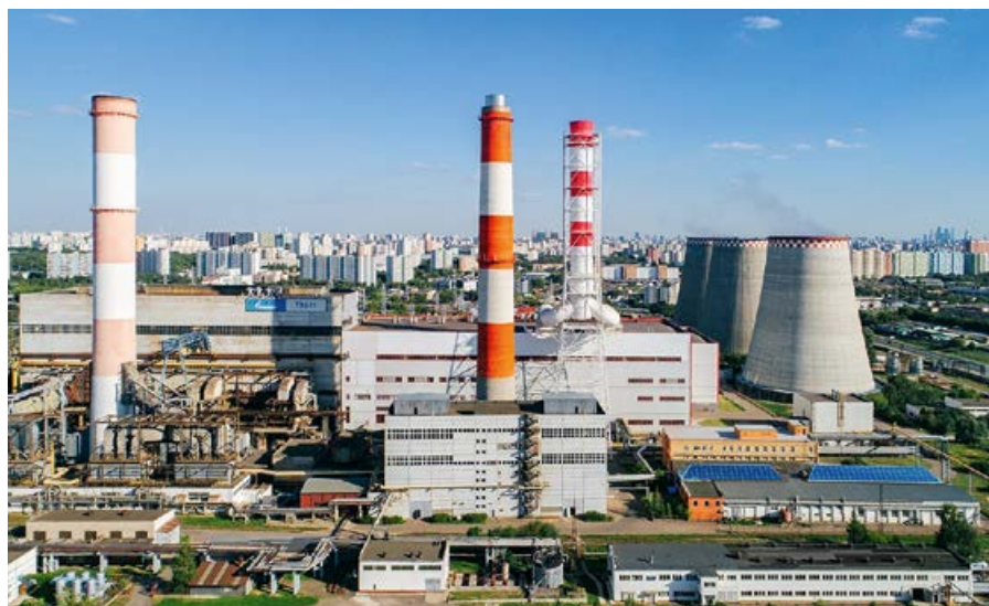
Московская ТЭЦ-21 (1765 МВт, 4918 Гкал/ч) введена в эксплуатацию в 1963 году
