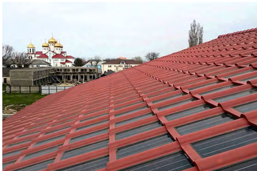
Рис. 2. Солнечная черепица имеет защитное антивандальное покрытие из закалённого стекла
