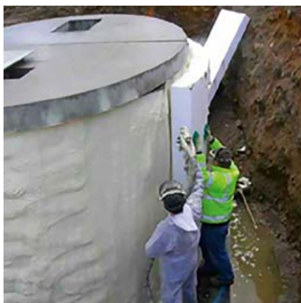
Рис. 2. Процесс монтажа теплоизоляции теплового аккумулятора [6]
