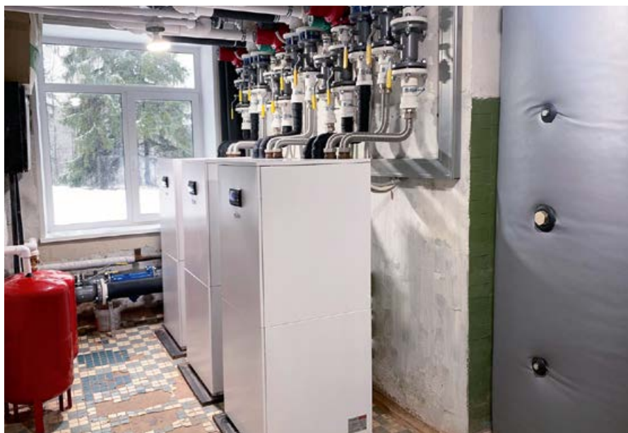
Здание школы (МБОУ «Житковская СОШ») в посёлке Житково Выборгского района Ленинградской области отапливается ГСТ с тремя тепловыми насосами Thermex Energy Pro 35 (112 кВт)
