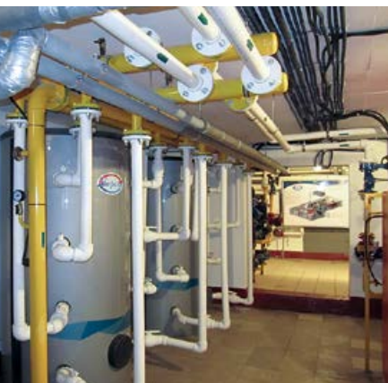
Энергоэффективный дом в посёлке Решетниково Клинского района (ул. Парковая, д. 3) оборудован ГСТ с 65 скважинами и четырьмя тепловыми насосами «Корса-55» (165 кВт)
