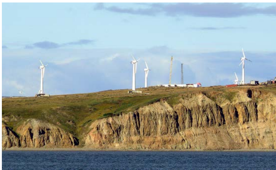
Анадырская ВЭС на мысе Обсервация, Чукотский АО
