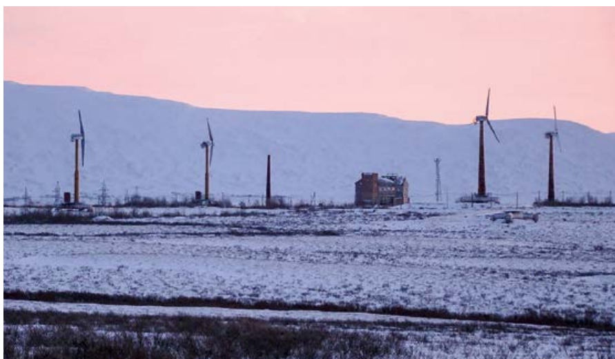
Воркутинская (Заполярная) ВЭС в наши дни
