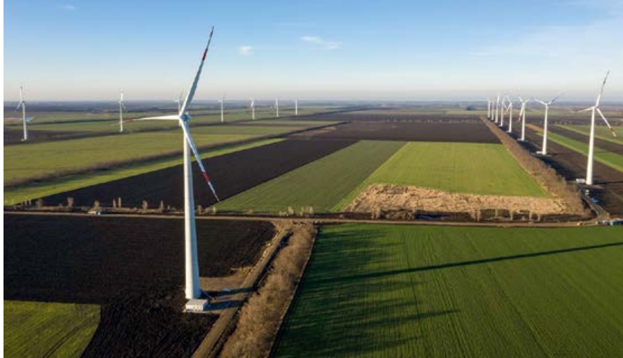
■ Адигейская ВЭС (мощность 150 МВт) — самая большая российская ветроэлектростанция
