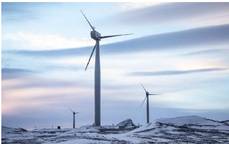
ВЭУ V3C Ghrepower-50 (мощностью 50 кВт, в арктической версии) около посёлка Амдерма
