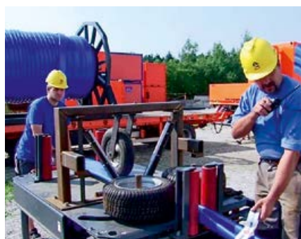
Рис. 4. Общий вид транспортной бобины и машины для складывания рукава Primus Line
