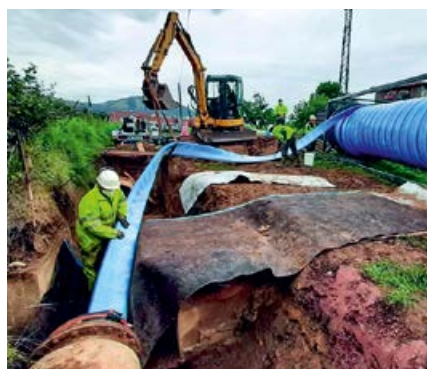
Рис. 4. Общий вид транспортной бобины и машины для складывания рукава Primus Line
