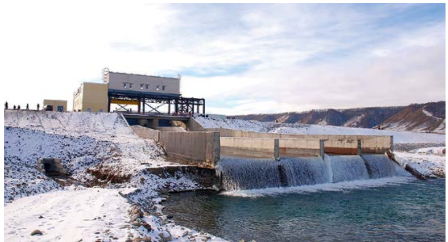
Малая гидроэлектростанция на реке Большой Зеленчук, Карачаево-Черкесия
