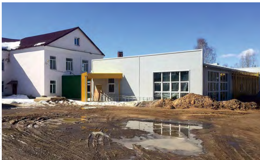
❖ Здание Кадыкской средней школы со строящейся столовой
