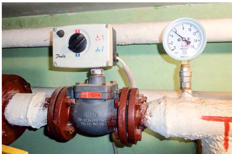
❖ Фото 3. Регулирующий фланцевый клапан типа VB2 с редукторным электроприводом AMV10 для управления им производства Danfoss
