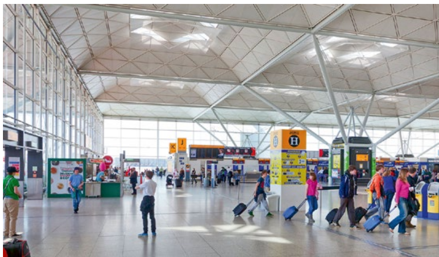
Рис. 2. Крыша аэропорта Станстед в Лондоне была оборудована первыми в мире сифонно-вакуумными водостоками [2]
