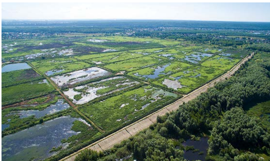
•• Иловые поля очистных сооружений города Казань
