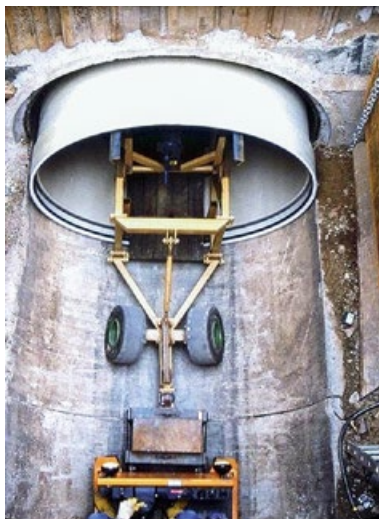
Рис. 1. Укладка труб методом бестраншейной прокладки
