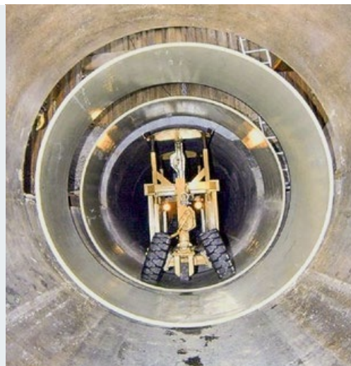
Рис. 1. Укладка труб методом бестраншейной прокладки
