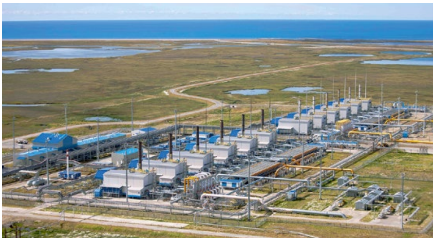
КС-1 «Байдарацкая» — самая северная в мире. Общая мощность агрегатов — 192 МВт
