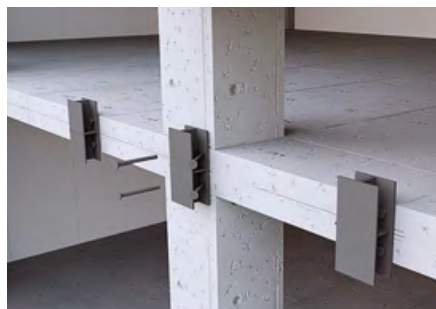
Рис. 4. Крепёжный элемент для крепления многослойной фасадной панели
