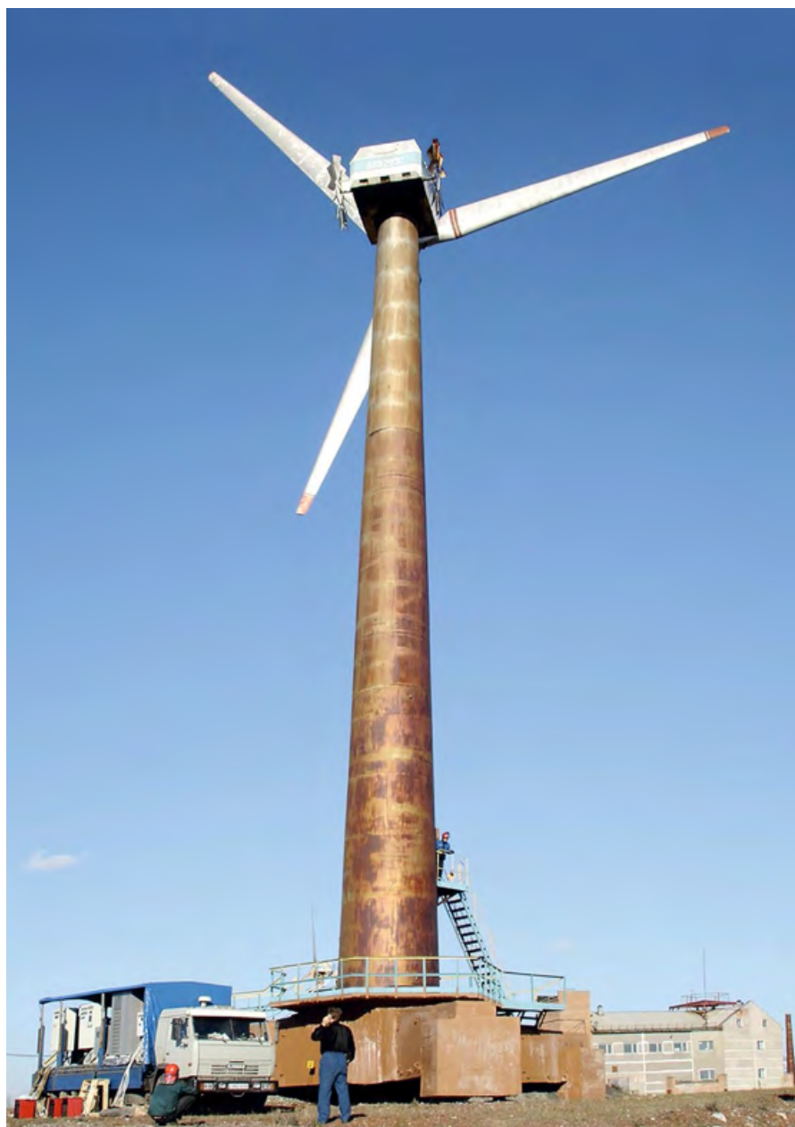
Рис. 2. Полевые испытания многофункционального энерготехнологического комплекса на базе ветроэлектростанции «Заполярная» (город Воркута) и всережимного двигатель-генератора
