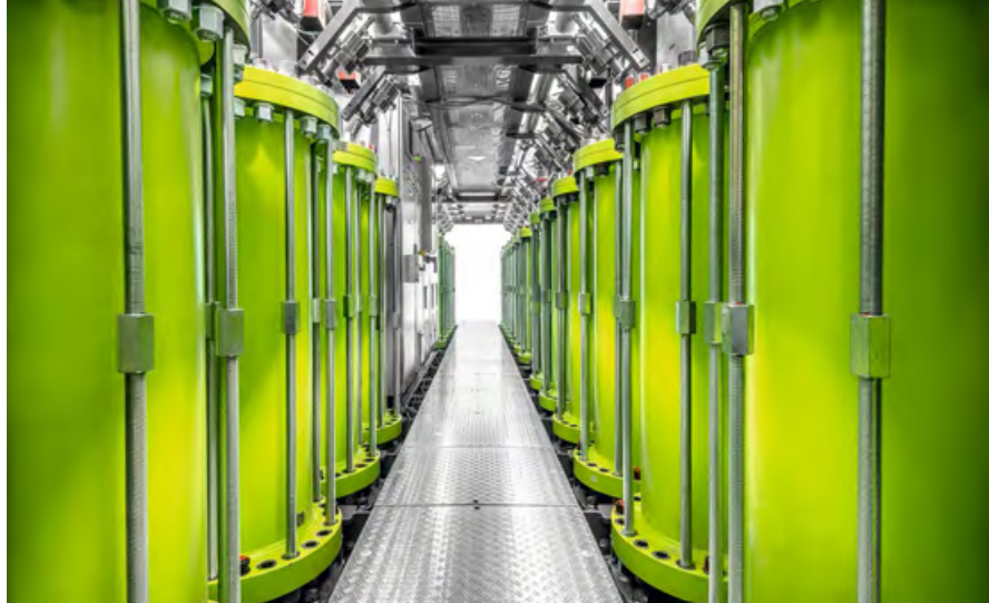
Блок накопления кинетической энергии, используемый в ЖКХ города Мюнхена, Германия
