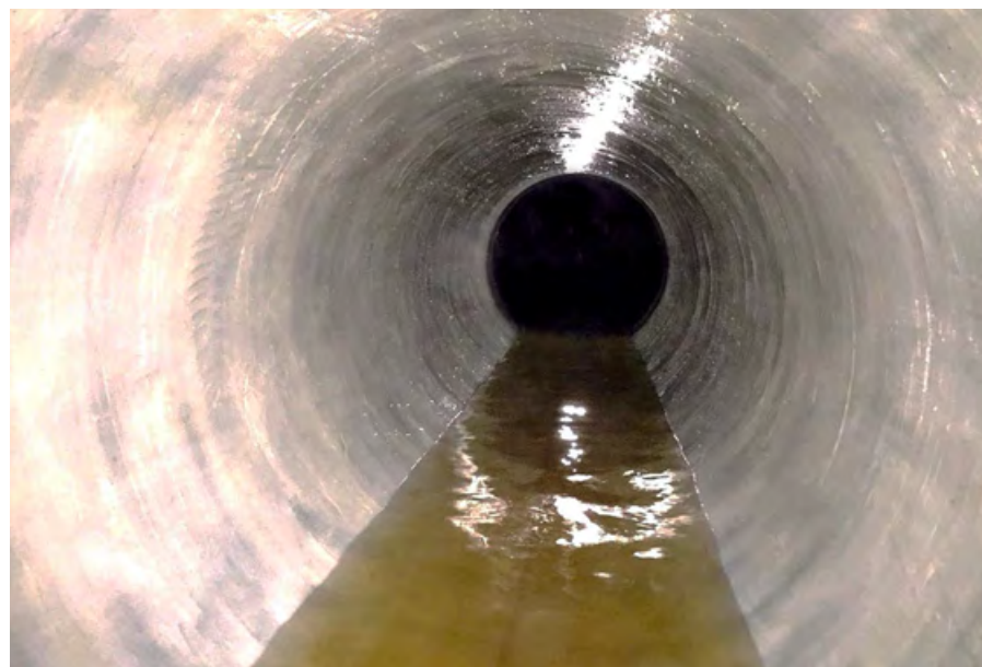
•• Рис. 3. Общий вид восстановленного комбинированной технологией трубопровода
