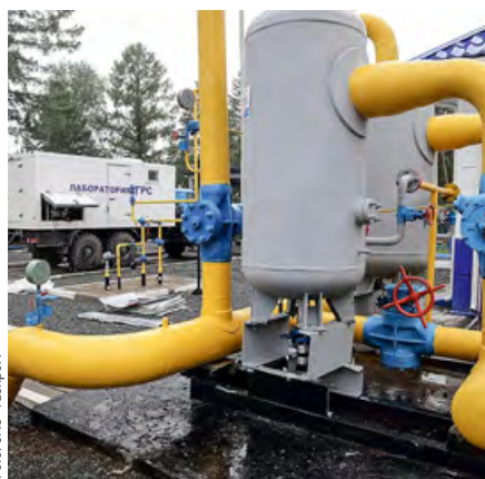
Фото: ОАО «Газпром»
