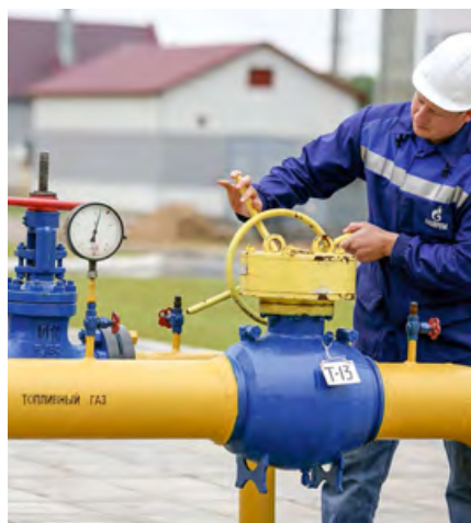
Фото: ОАО «Газпром»
