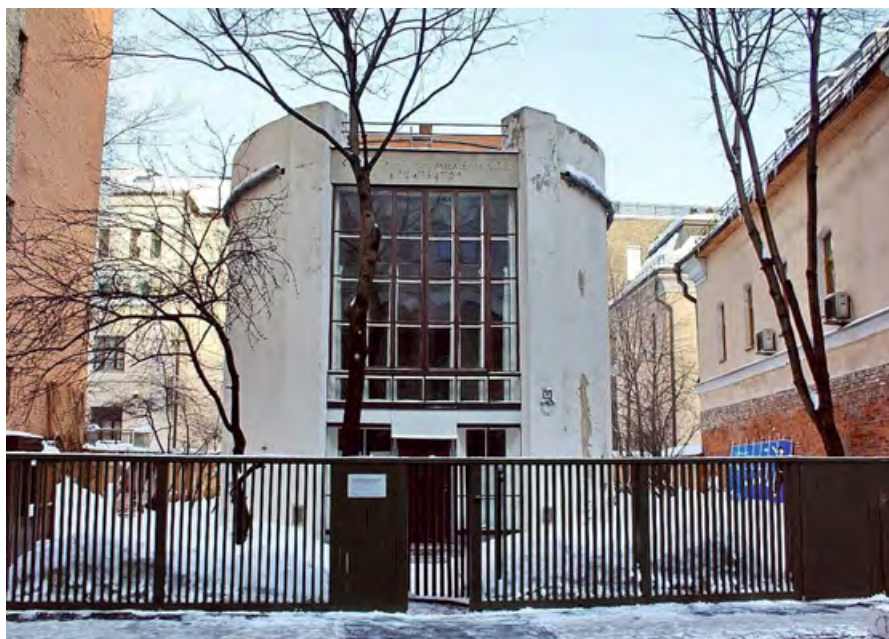
❖ Фото 1. Вид здания со стороны Кривоарбатского переулка
