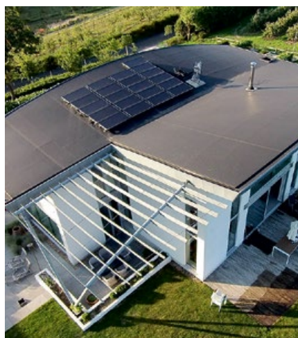
Гибридный PVT-модуль на крыше дома
