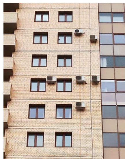
❖ Фото 1. Крепление наружных блоков кондиционеров к лицевому слою многослойных стен
