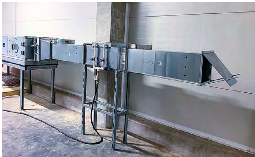
Рис. 2. Конструкция опытного стенда
