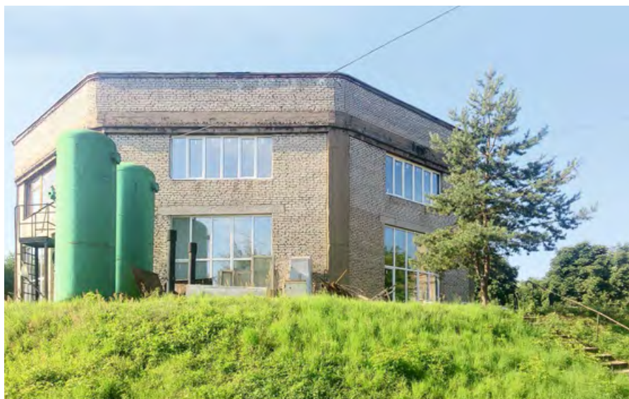
Станция ВЗУ-2 в городе Жуковский Московской области
