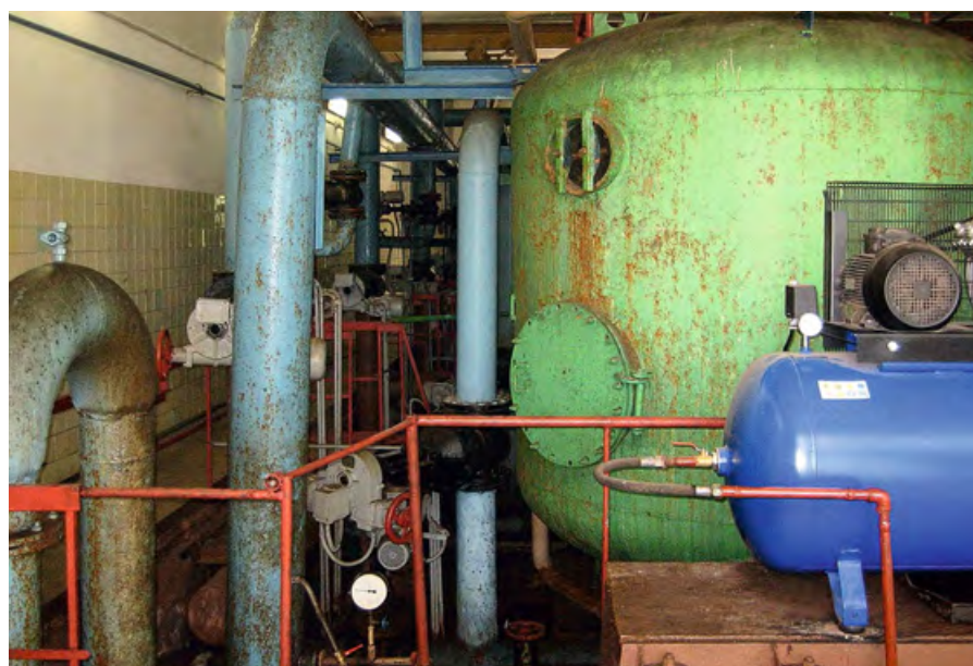
:: Рис. 4. Станция обезжелезивания до реконструкции (фильтры ФОВ-2,5-6)
