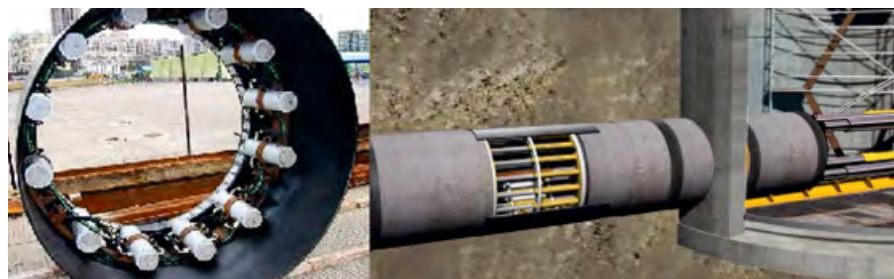
Рис. 6. Промежуточная домкратная станция
