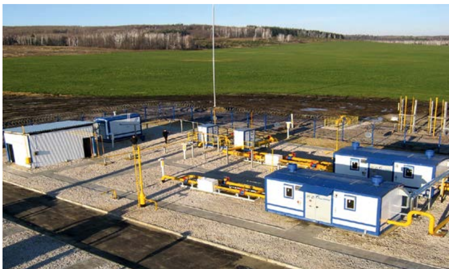
Автоматизированная газораспределительная блочная станция АГРС «Саратов-М(70)»
