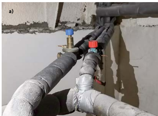
❖ Фото 4. Неработоспособные регулирующие клапаны (а — регулирующий клапан с обрезанной и обжатой импульсной трубкой, б — регулирующий клапан заменён на шаровой кран)
