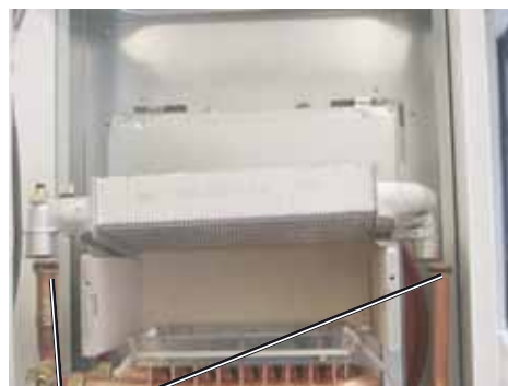
Рис: Демонтаж теплообменника сетевой воды
